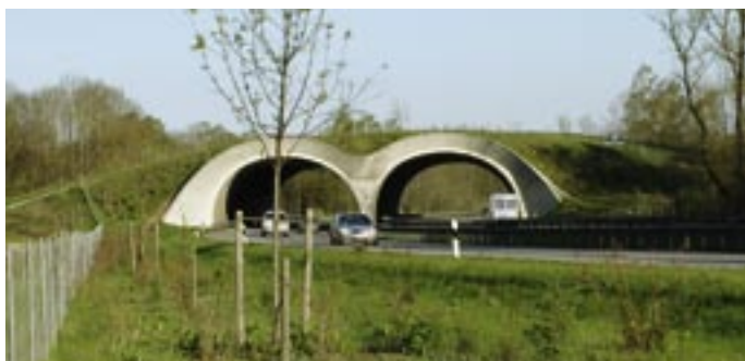
Auf Anregung des BJV werden heute beim Neu- und Ausbau von Fernstraßen Grünbrücken als Querungshilfen fürs Wild errichtet.
