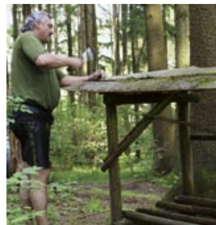
Reviereinrichtungen werden kontrolliert und gegebenenfalls repariert.
