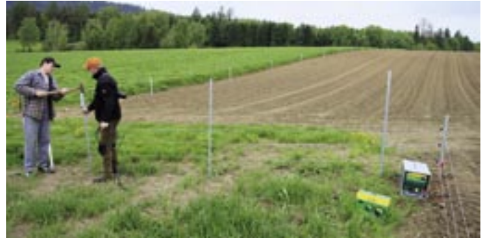
Einer der Hauptfehler beim Aufstellen eines Elektrozaunes ist eine zu schwache Erdung des Stromgerätes. Zur optimalen Erdung muss eine ausreichende Anzahl von Erdstäben in den Boden geschlagen werden.
